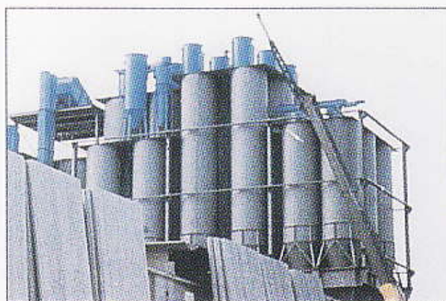
Montaggio impianto di filtrazione. Filtration plant assembly.
